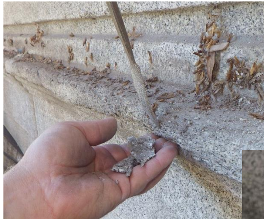
Désagrégation sableuse du granite
