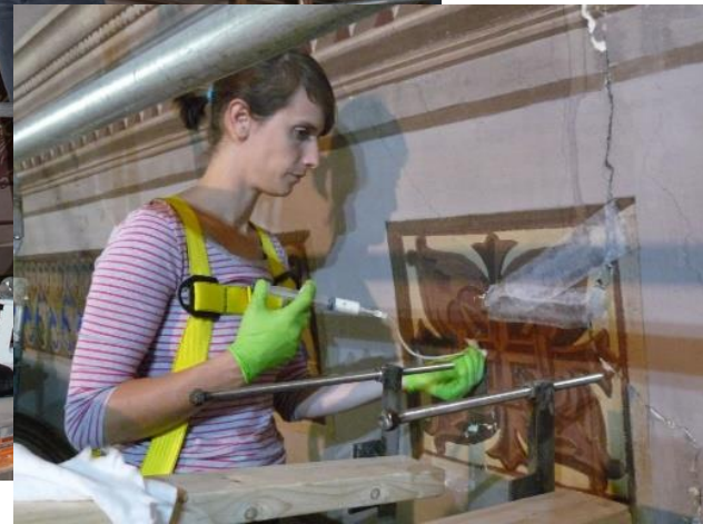
Injection de coulis de chaux pour le comblement des fissures
