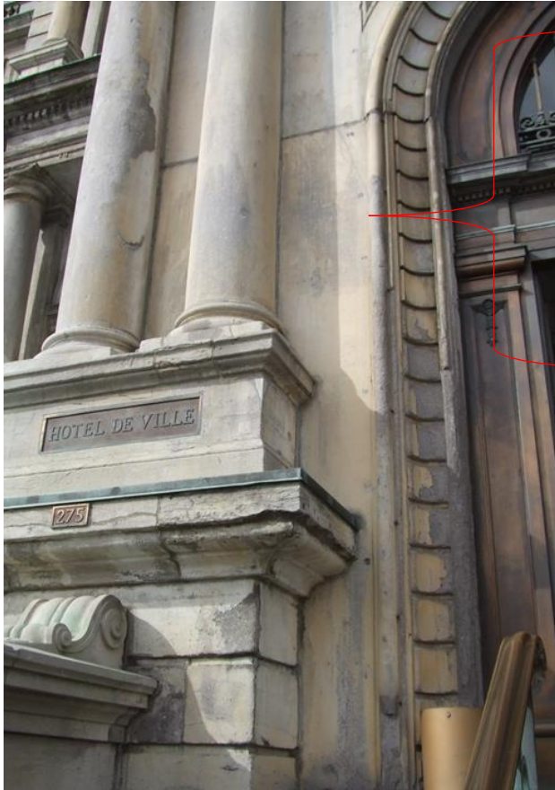
Coloration jaunâtre du calcaire (pierre grise de Montréal) à la suite d'un ancien nettoyage à l'acide fluorhydrique
