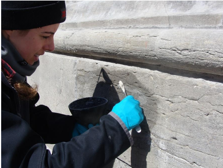
Comblement des fissures
