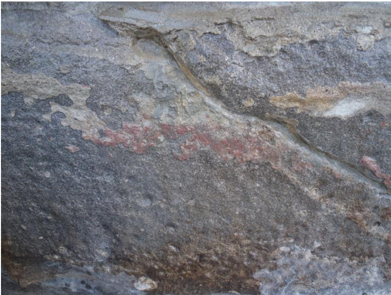
Fragment d'enduit de chaux rosée (ocre rouge et jaune)
