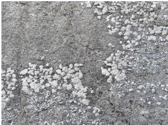
Prélèvements et identification des sels
