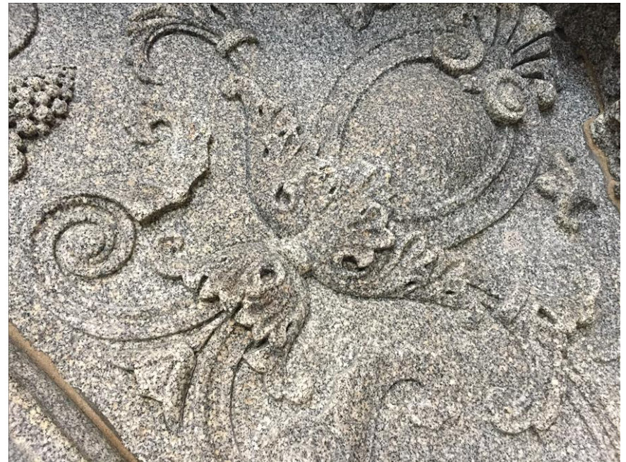
Détail des reliefs après la consolidation
