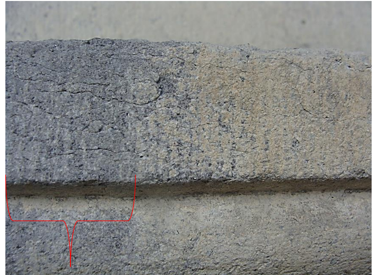
Traces d'outil encore visibles après hydrosablage
