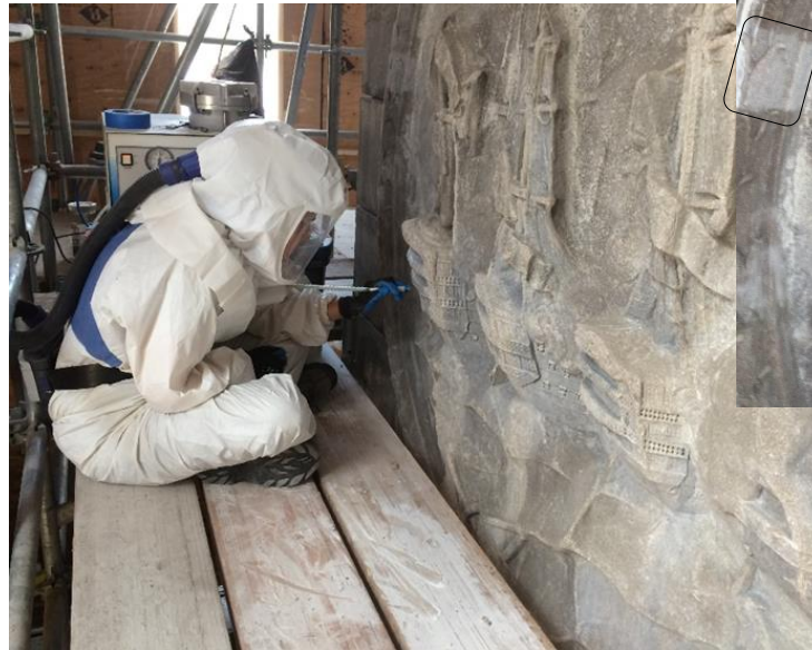
Retrait des taches de pollution par microabrasion
