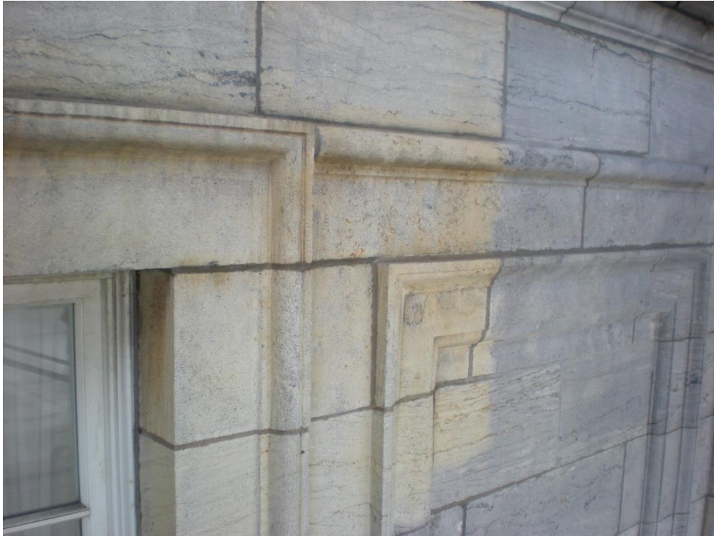
Retrait de la couche par hydrosablage
