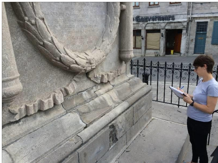
Examen et relevé des altérations du piédestal
