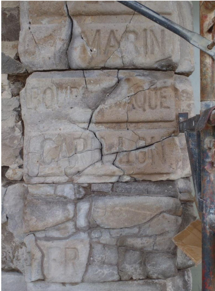
Traitement des fissures : avant
