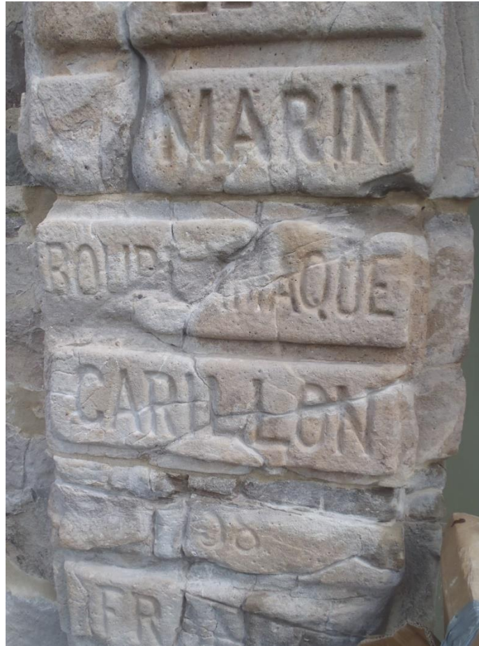
Traitement de fissures : après
