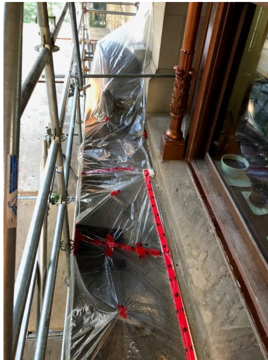
Protection contre la pluie pendant la réaction d'hydrolyse
