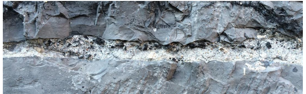
Mortier ancien avec du sable de granulométrie variée
