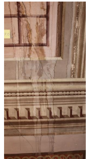
Domages provoqués par les infiltrations d'eau
