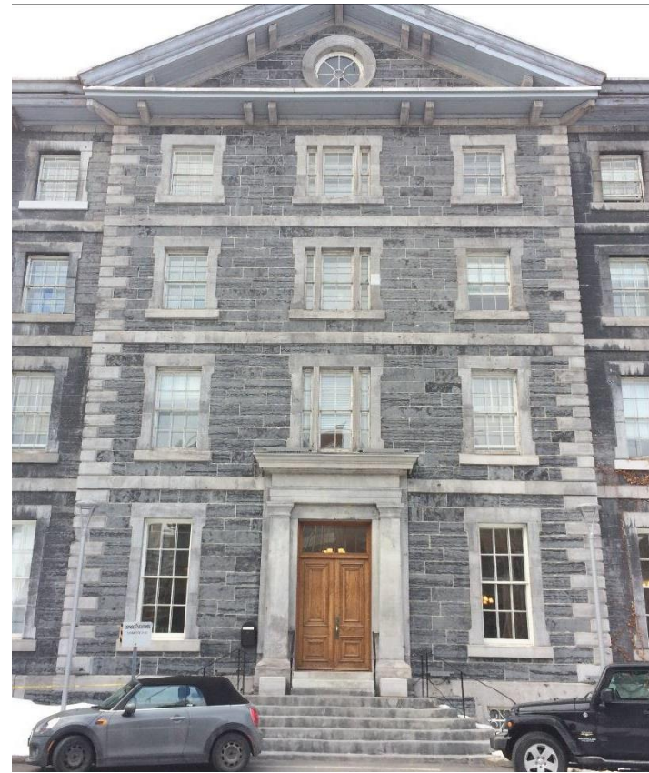
Après nettoyage à l'eau (nébulisation)
