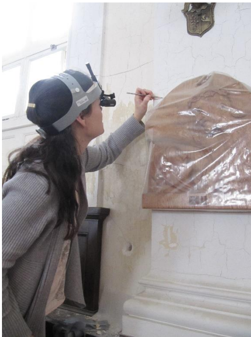
Craquelures sur l'ensemble des murs et de la voûte
