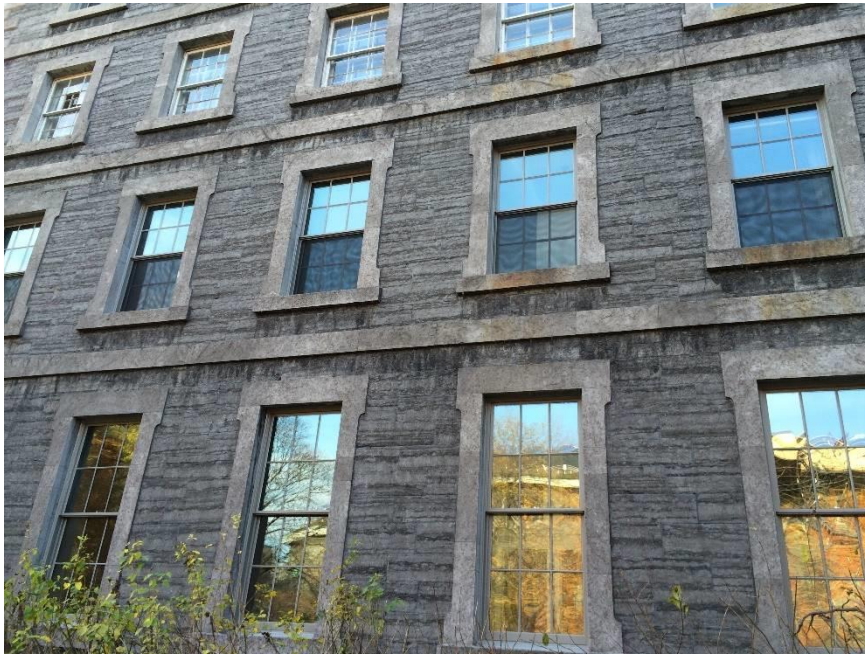
Lits de shales noirs sur la pierre du parement
