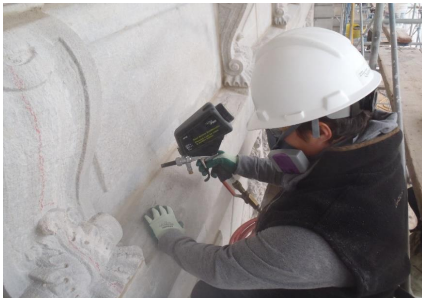
Tests de microsablage sur la pierre
