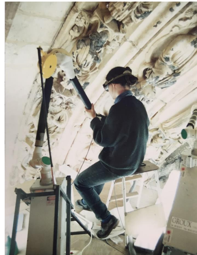
Stage en chantier, cathédrale d'Amiens
