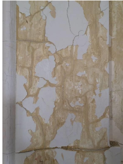
Craquelures sur l'ensemble des murs et de la voûte
