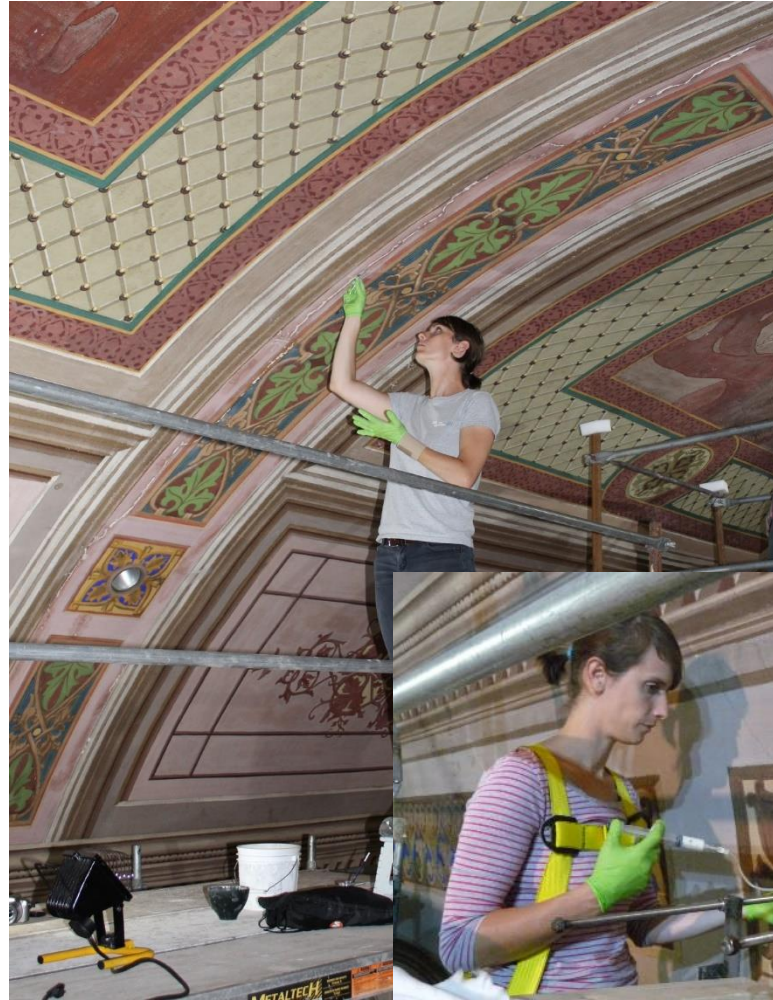
Injection de coulis de chaux pour le comblement des fissures
