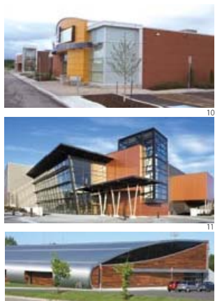
10 - Revêtement en panneaux d'aluminium d'Alutech Architectural peint aux couleurs de l'institution bancaire. Ce système dont les fixations sont dissimulées est conforme aux exigences réglementaires en matière d'écran pare-pluie.
