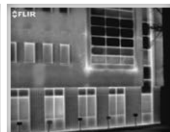
Figure 6 : Exfiltration d'air notée dans les coins inférieurs d'un mur-rideau (bâtiment en pression positive).
