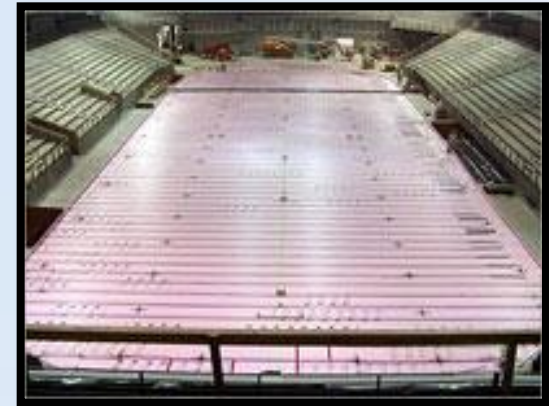
Isolants haute densité (résistance à la compression élevée)
