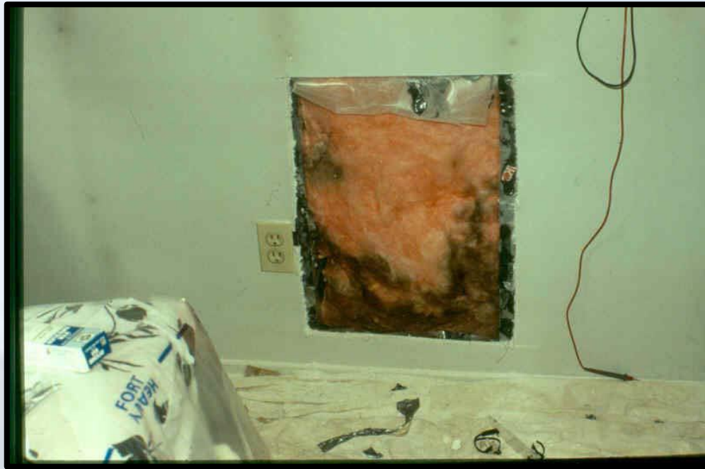
Saleté déposée sur l'isolant par fuite d'air
