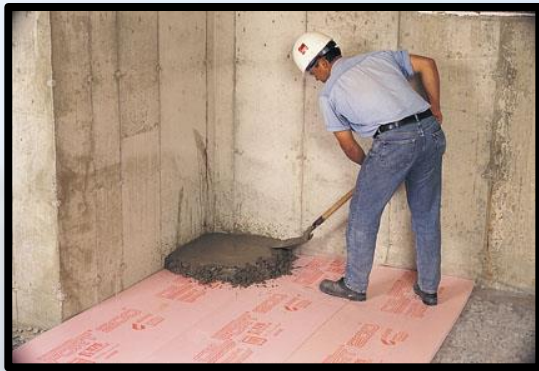
Isolation sous dalle
