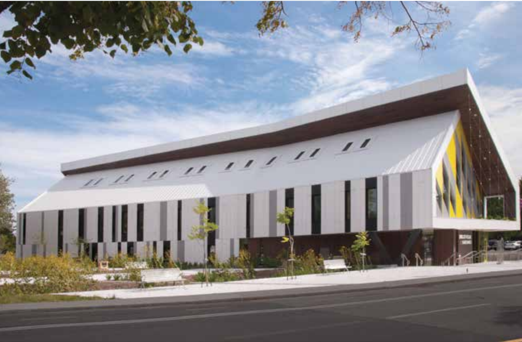
La façade nord est fenêtrée à 15 % pour réduire les déperditions de chaleur. Sur le toit, des lanterneaux apportent une lumière naturelle. Source : Maxime Gagné - Architectes en consortium : Labbé - Laroche et Gagné - Leclerc et associés
