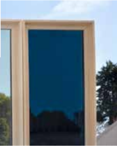
Travaux de démonstration et d'essais de verres électrochromes réalisés au Lawrence Berkeley National Laboratory Source : Roy Kaltschmidt
