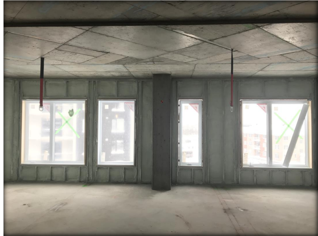
Le Bâtiment K
