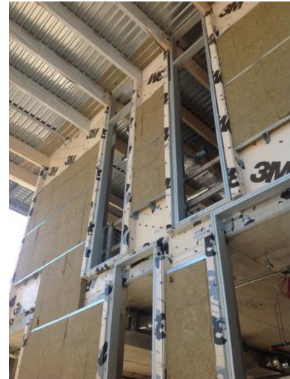
Continuité du système de pare-air
